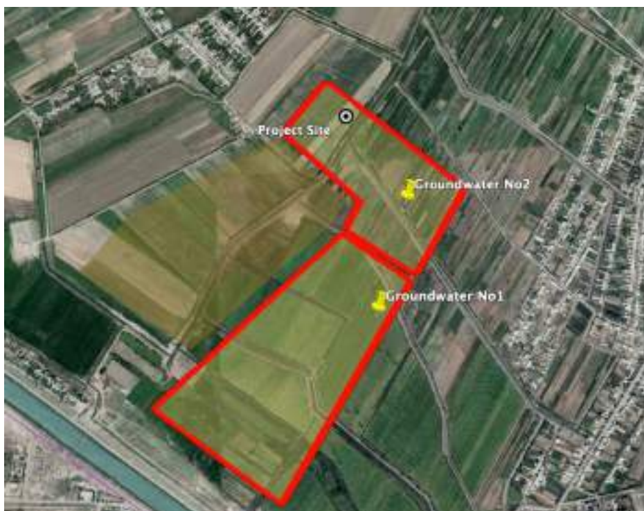
Рисунок 9-3 Места отбора проб грунтовых вод
