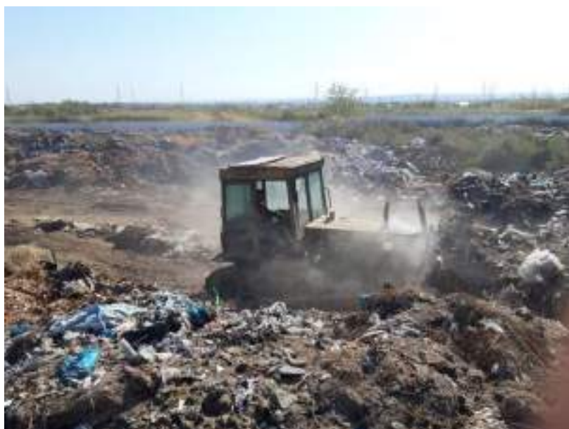
Рисунок 10-1 Полигон для отходов
