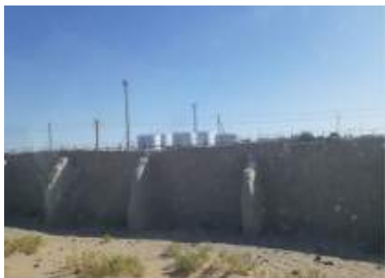
#R14– Вид на газохранилища с подъездной дороги
