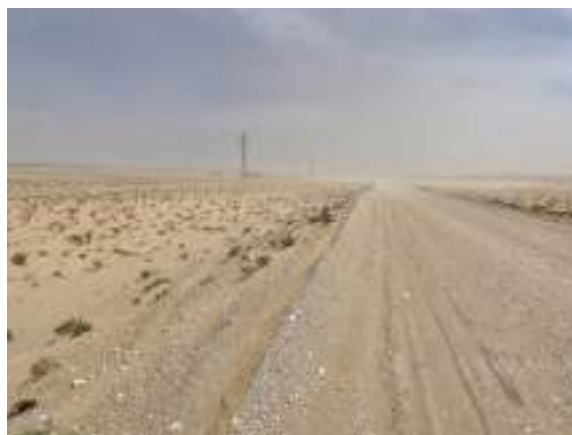
Вид на ВЛЭП вдоль подъездной дороги
